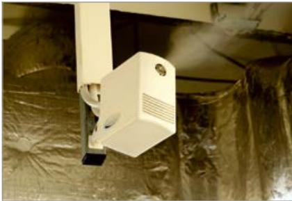
Hochdruck-Düsen vernebeln mikrofein bei Bedarf die benötigte Wassermenge in die Luft.
