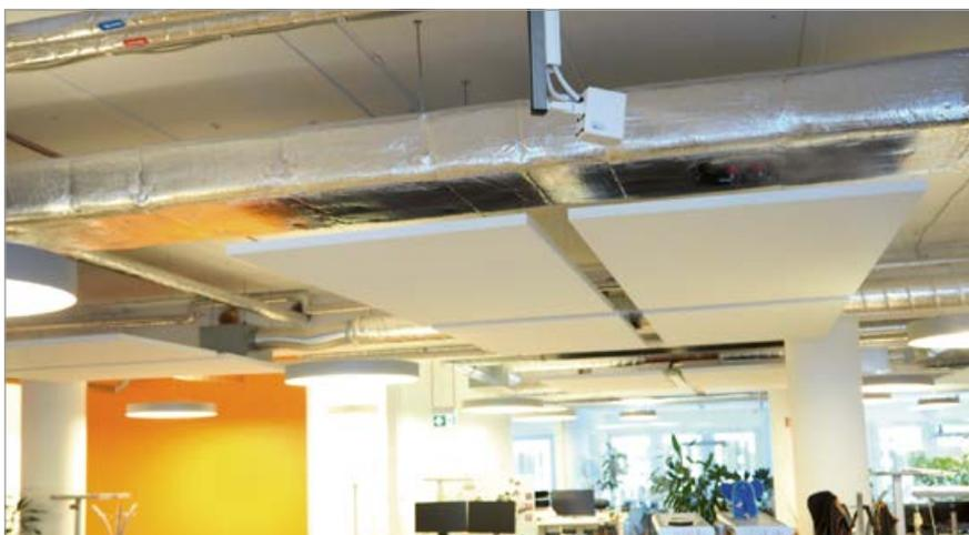
50 Direkt-Raumluftbefeuchter sichern bei AOE eine Luftfeuchte von 40 Prozent.
